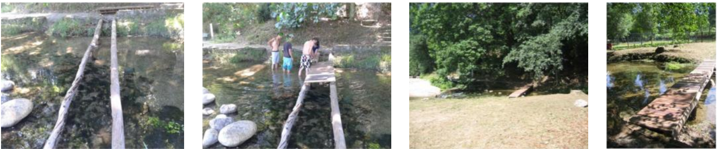
As várias fases de construção da Ponte
